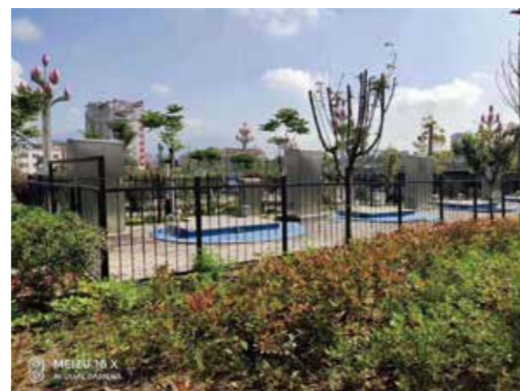
陕西勉县雨水泵站
