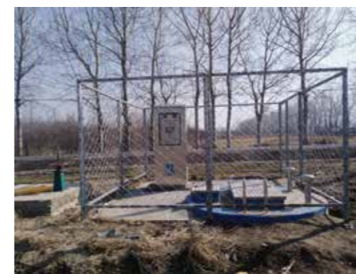
青云店镇泵站
